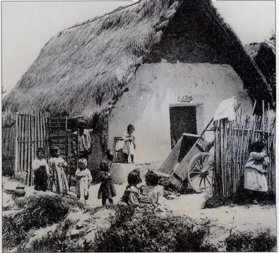
La barraca au toit de chaume de jonc est l'habitat traditionnel de la huerta de Valence. Celle-ci, à l'entrée du Palmar, était au début du siècle l'école primaire des enfants de la communauté.
